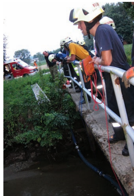
Aufbau einer Ölsperre in Kotezicken
